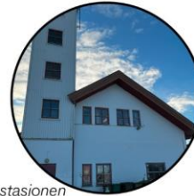
Gamle Brannstasjonen Ubrukt potensiale
