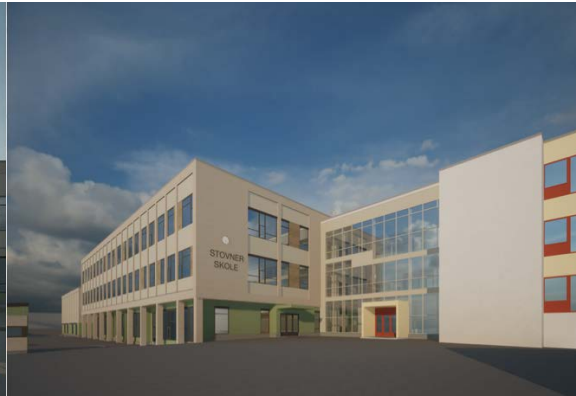
En glassvestibyle binder sammen nytt tilbygg og
