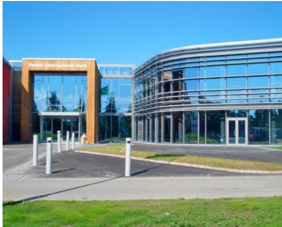
Bildet viser hovedinngangen i anlegget (denne delen av eksisterende anlegg beholdes) med
